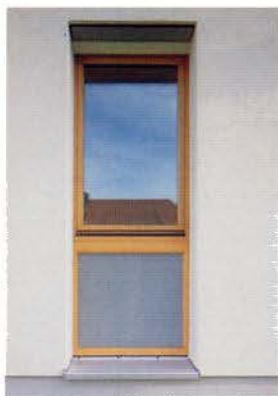
fig. 5-7 Parois portes pivotantes dans l'appui de fenêtre
