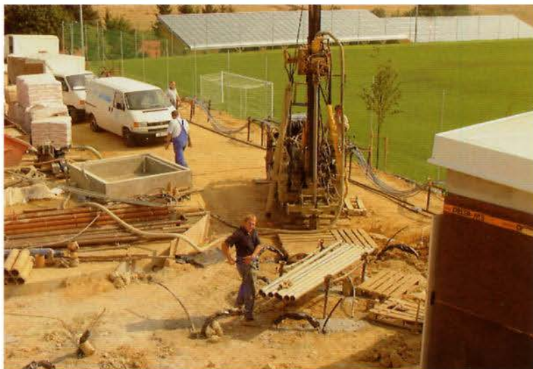
fig. 3-19 Forage d'un collecteur vertical
