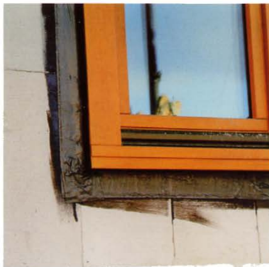
fig. 2-34 Encastrement d'une fenêtre - joint d'un châssis de fenêtre
