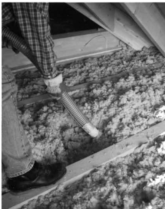
fig. 2-30 Injection de l'isolant de laine de chanvre dans le solivage de comble
