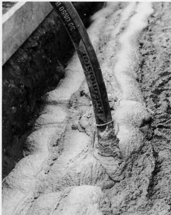
fig. 2-5 Béton cellulaire appliqué à l'aide d'une pompe à béton
