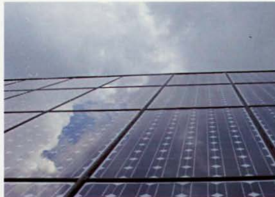
fig. 2-26 Panneaux solaires monocristallins - côté nord du toit
