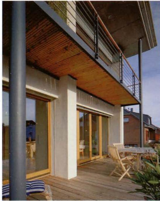
fig. 5-6 Ombrage constructif par le balcon et la toiture
